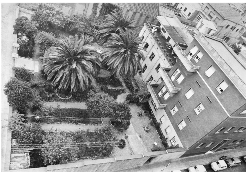
L'edifici antic, el construït el 1959 i el jardí, tot just abans de les obres.
